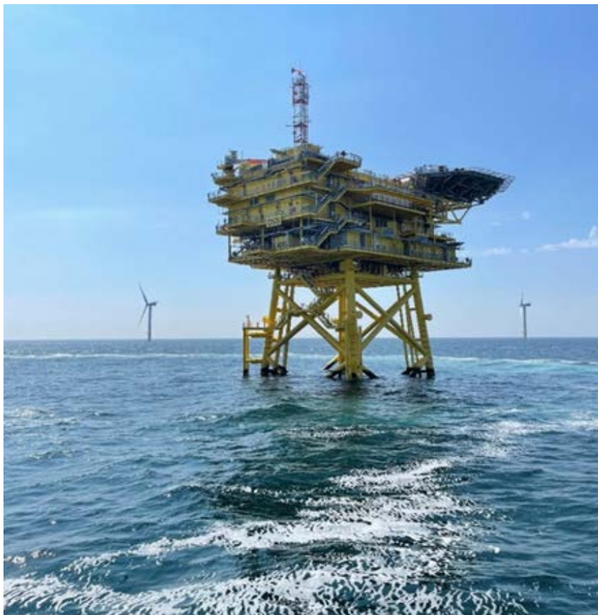
Rys. 7. OSS ( helideck ) Morze Północne
