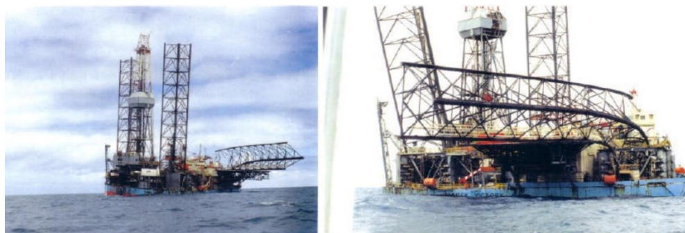
Rys. 5. Maersk Victory – 1996, uszkodzone nogi w wyniku przepadnięcia
