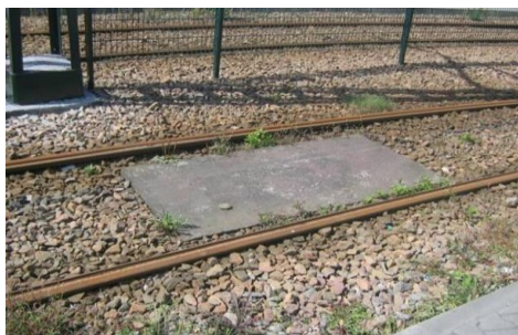
Rys. 3. Pętla indukcyjna jako detektor dla tramwajów
