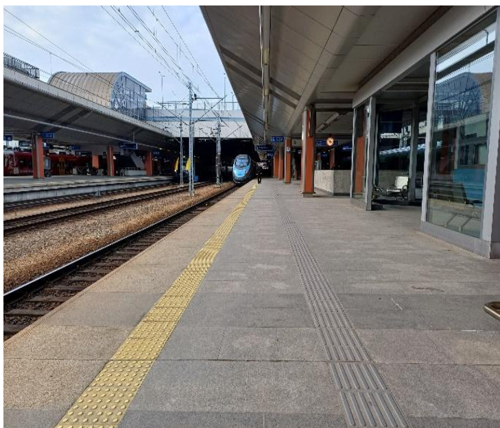
Rys. 6. Ścieżki dotykowe dla niewidomych oraz kontrastowa krawędź na peronie
