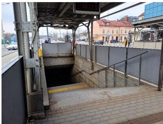
Rys. 1. Wejście do przejścia podziemnego na przystanku Plac Bohaterów Getta w Krakowie
